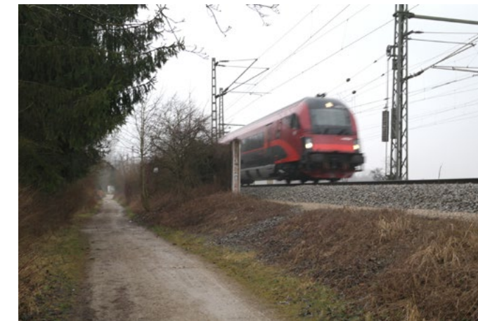
... die Lärmschutzwand existiert in Zorneding nur auf der südlichen Seite der Bahn auf einer Länge von knapp 1,8 Kilometern ab kurz nach der Brücke der Staatsstraße 2081 bis kurz nach der Schwanenland Gartenbauschule unterhalb dem Daxenberg (siehe Bild). Auf der Pöding Seite der Bahnstrecke gibt es leider keinen einzigen Meter Lärmschutzwand der Bahn. (Foto: Peter Pernsteiner)
