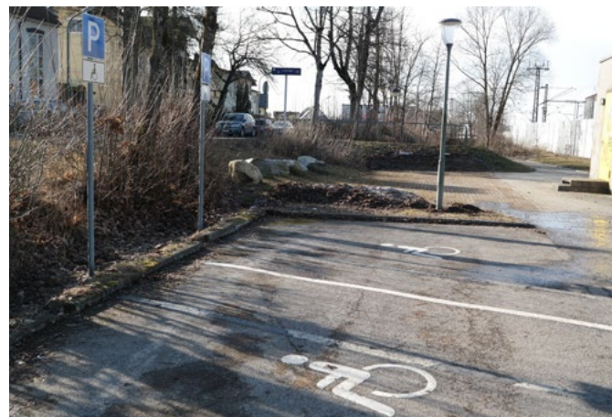
Mit der Beschilderung und Markierung von zwei Behindertenparkplätzen auf dem Bahnhofsparkplatz wurde eine von der FDP-Zorneding im Gemeinderat eingebrachte und einstimmig beschlossene Baumaßnahme im letzten Herbst abgeschlossen: Die Realisierung eines direkten Verbindungsweges vom Parkplatz zur Unterführungsrampe. (Foto: Pernsteiner)
