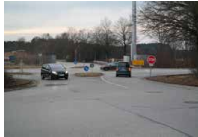
Noch in diesem Jahr soll endlich an der Staatsstraße 2081 beim Pörringer Gewerbegebiet ein Kreisverkehr gebaut werden, der die Unfallgefahr an der sehr unübersichtlichen Stelle hoffentlich deutlich reduzieren wird. (Foto: Pernsteiner)
