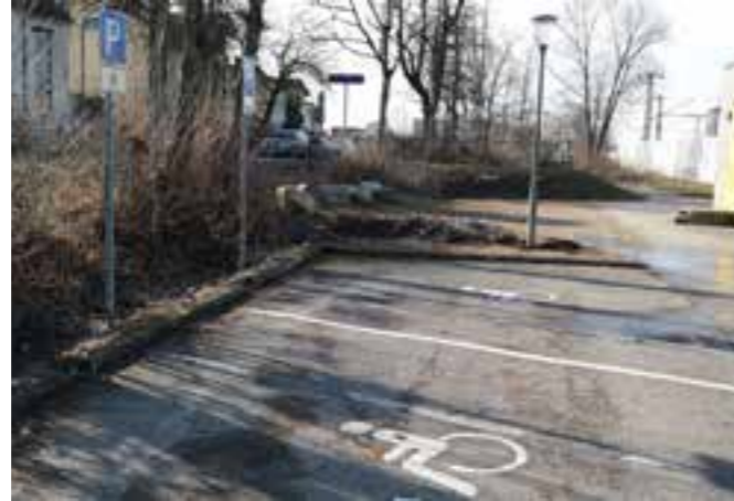
Mit der Beschilderung und Markierung von zwei Behindertenparkplätzen auf dem Bahnhofsparkplatz wurde eine von der FDP-Zorneding im Gemeinderat eingebrachte und einstimmig beschlossene Baumaßnahme im letzten Herbst abgeschlossen: Die Realisierung eines direkten Verbindungsweges vom Parkplatz zur Unterführungsrampe. (Foto: Pernsteiner)
